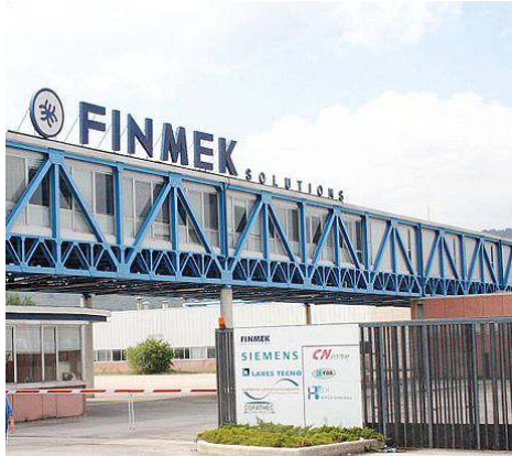
Lo stabilimento ex Finmek dove si ricollocerà l'Accord Phoenix
